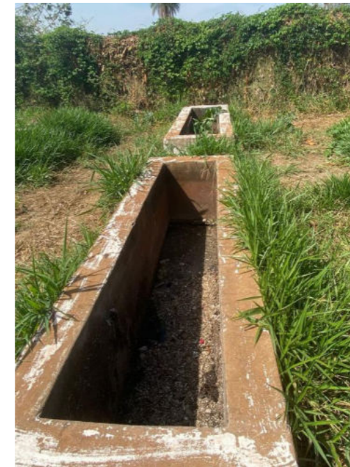
Figura 163 – Chegada do efluente na ETE Pioneiros.
