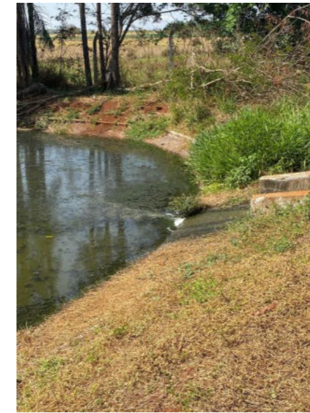
Figura 168 – Entrada do efluente na 2ª Lagoa Facultativa.
