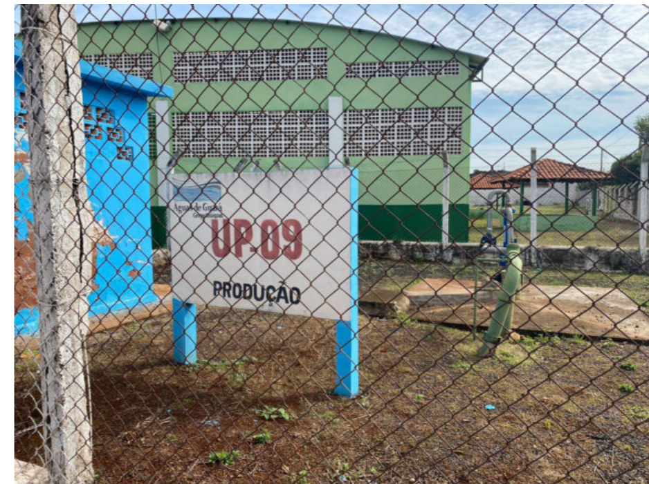
Figura 43 – Identificação do poço UP 09.
