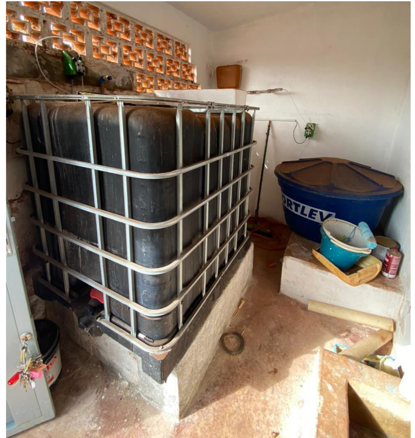
Figura 47 – Cloração e fluoretação.
