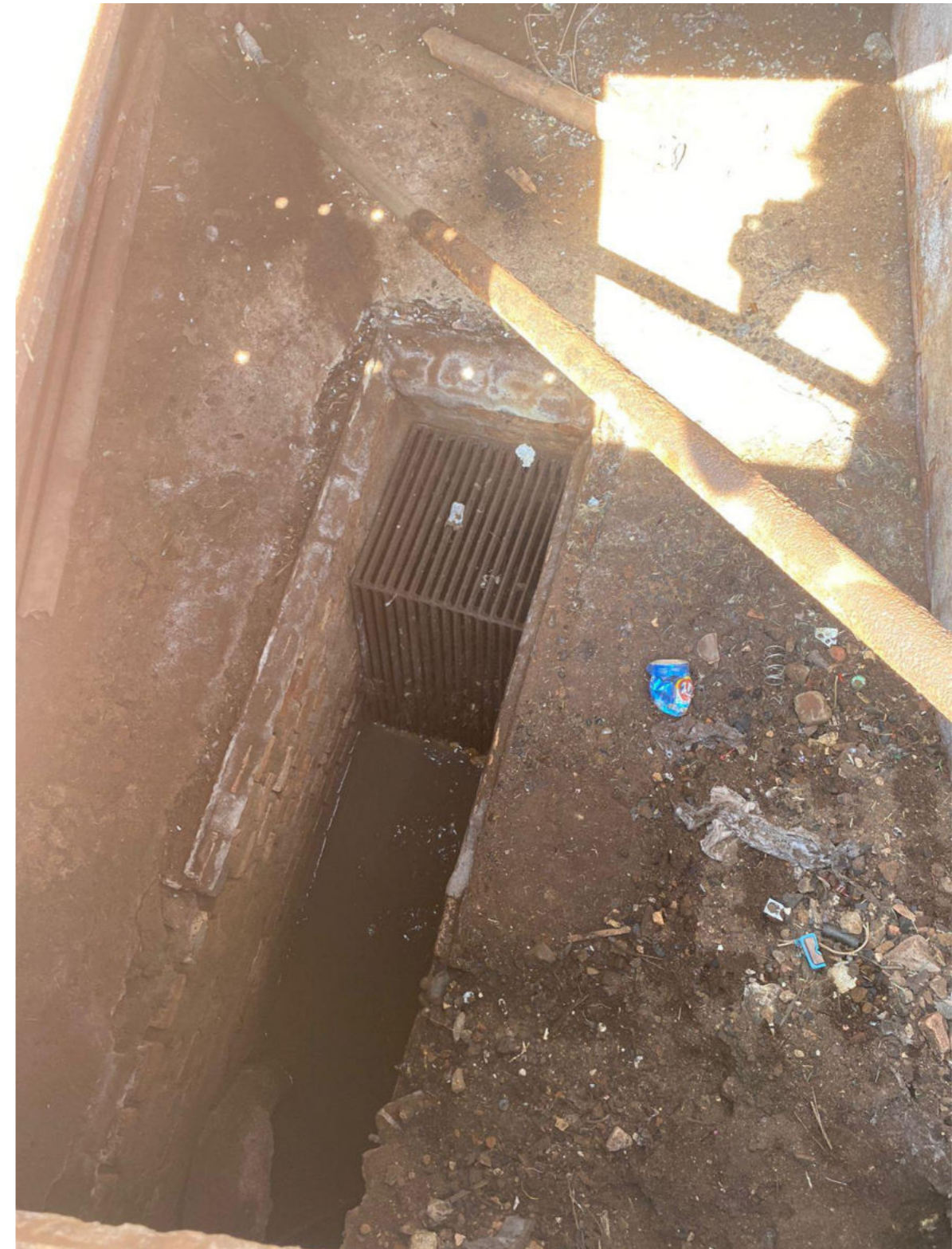
Figura 144 – Gradeamento da EEE Quinze de setembro.
