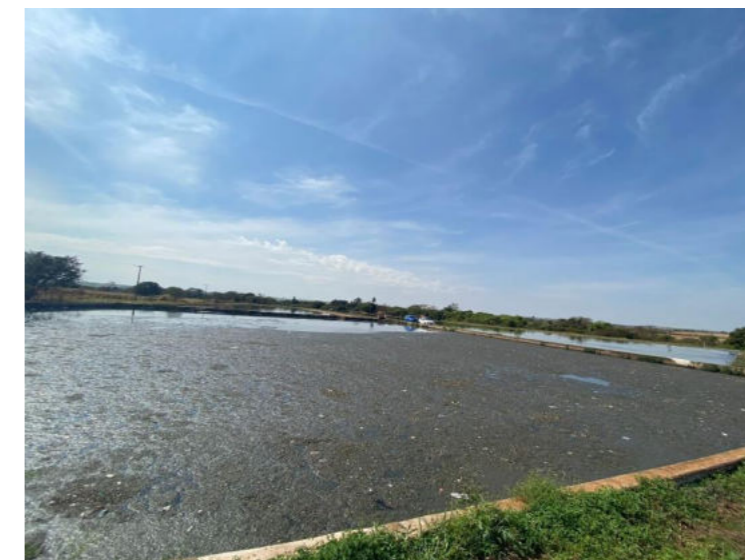
Figura 153 – Lagoa Anaeróbia (Parte 02)
