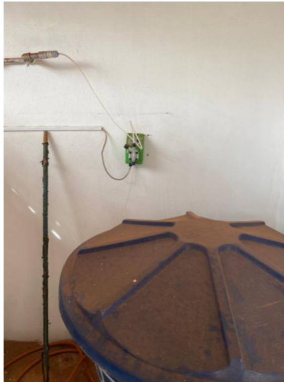
Figura 49 – Bomba dosadora de flor.
