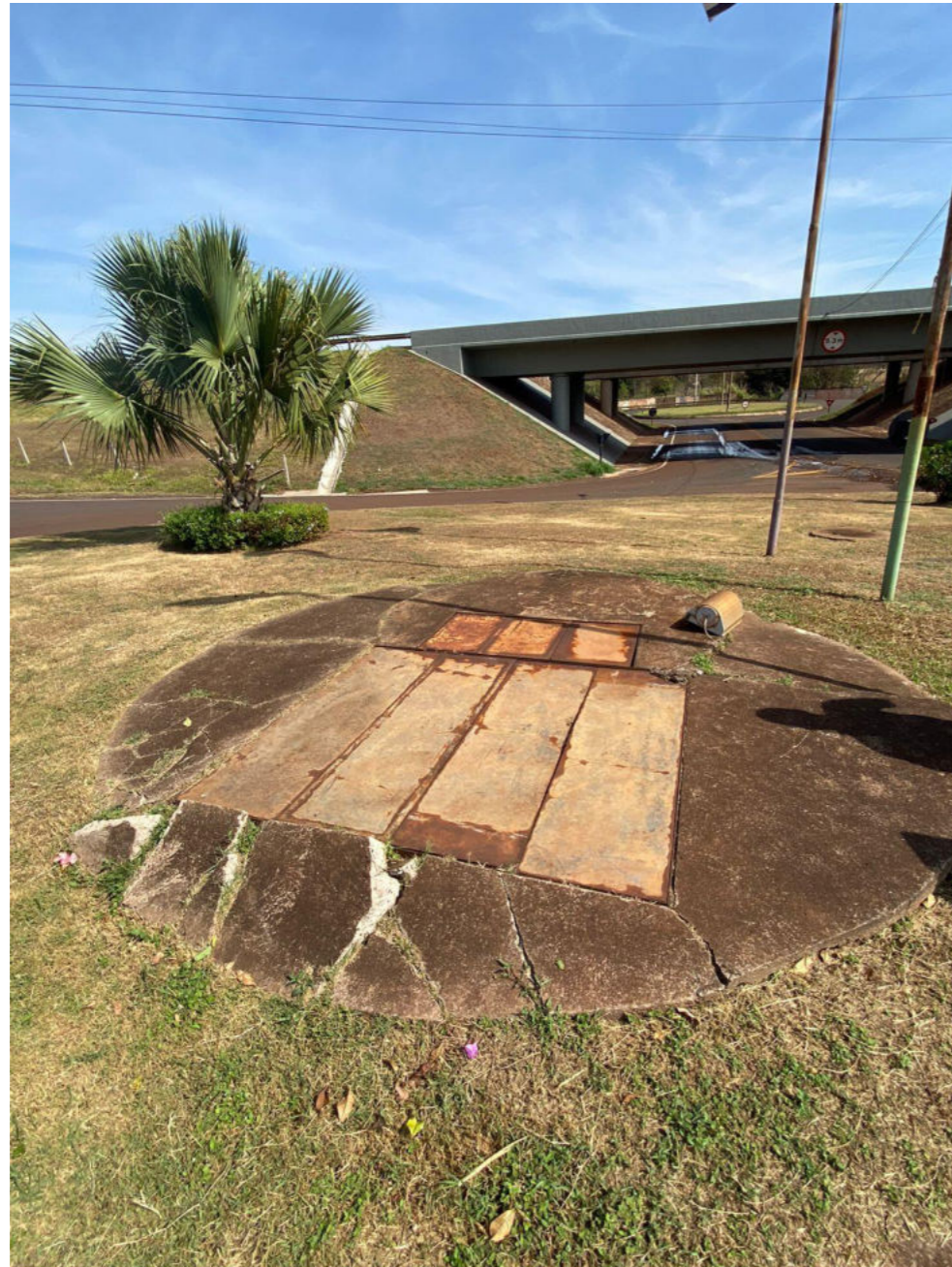
Figura 143 – Estação Elevatória de Esgoto Quinze de setembro.
