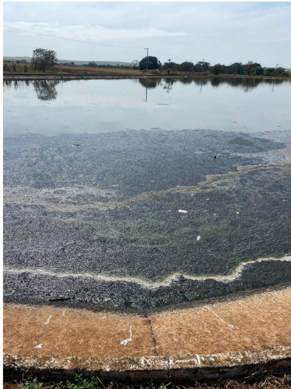
Figura 156 – Resíduos Sólidos no espelho da Lagoa Facultativa.
