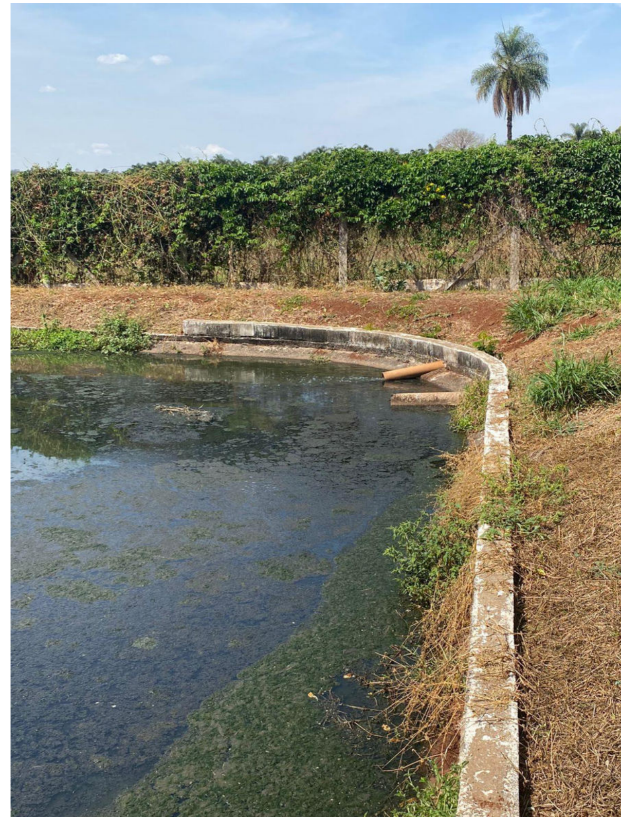
Figura 166 – Entrada do efluente na 1ª Lagoa Facultativa. (Parte 02)
