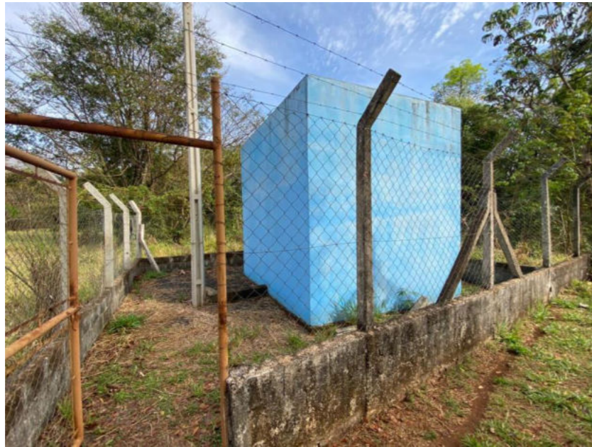
Figura 90 – Fachada Booster Itapema.
