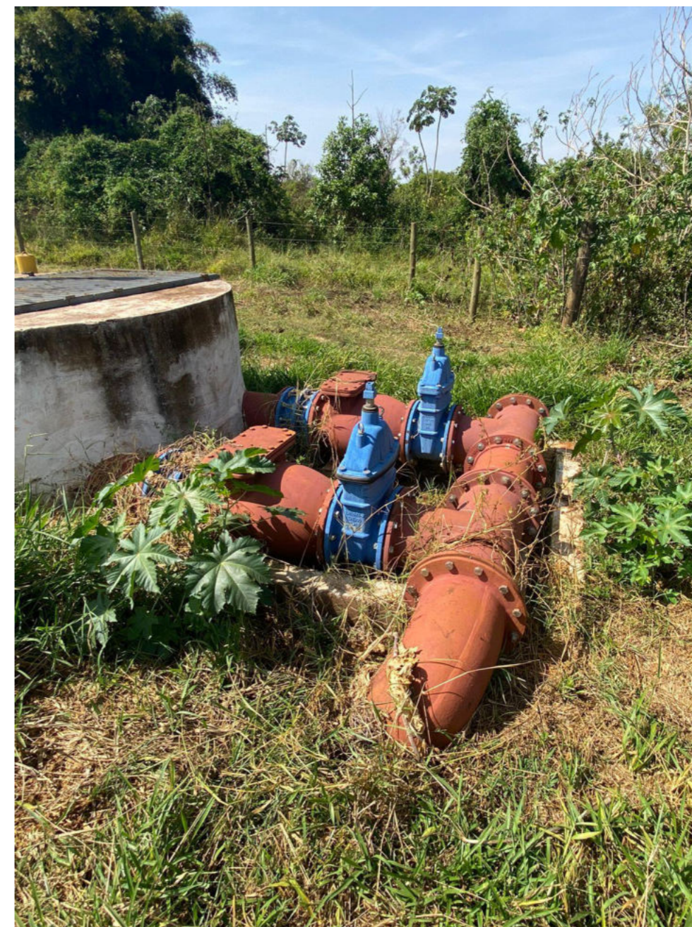
Figura 146 – Bombeamento da EEE da ETE Guará.
