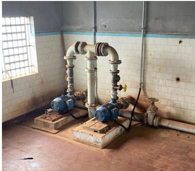
Figura 20 – Elevatórias para o poço UP06.
