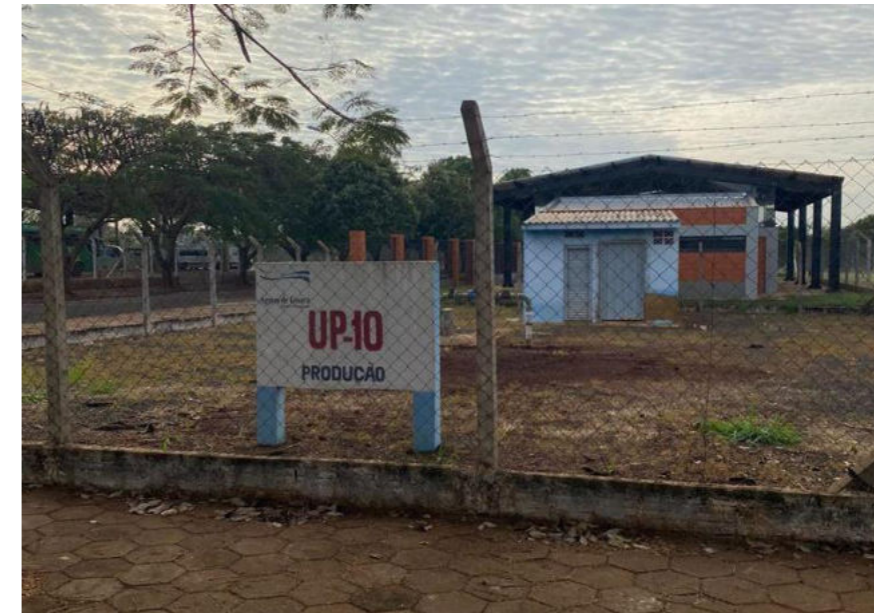
Figura 52 – Identificação poço UP 10.
