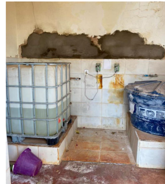
Figura 28 – Dosagem de cloro e flúor.
