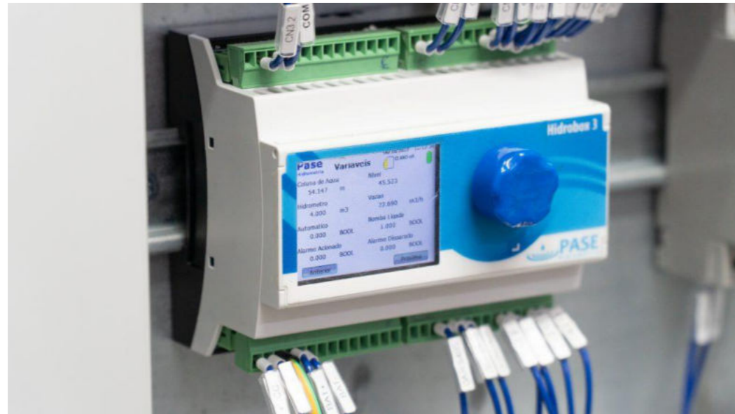
Figura 133-Modelo de automação para controle da vazão
